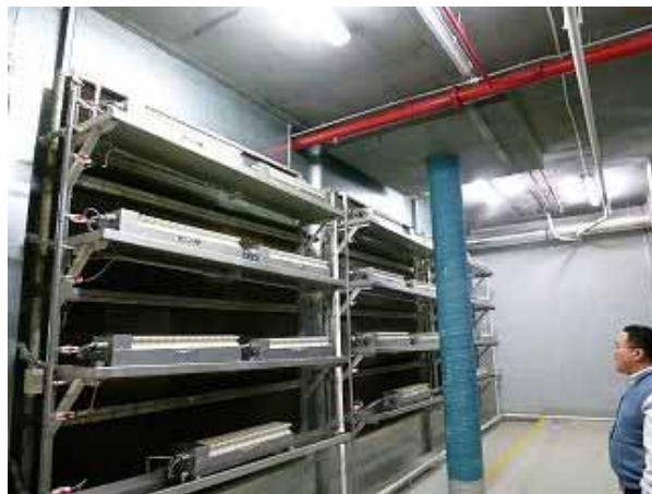
写真 2. National Gallery of Australia の巨大な空調機
