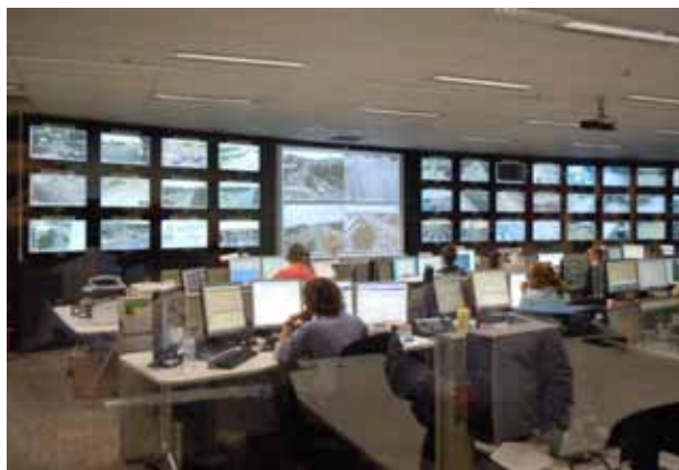
BMTMC の管制室
