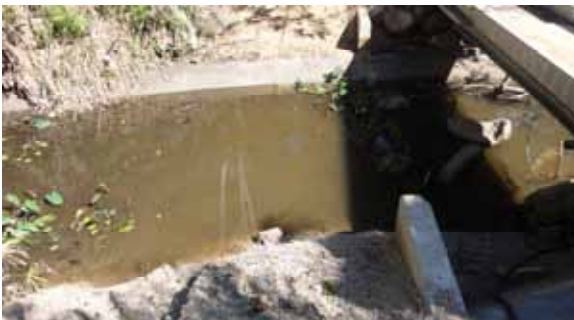
写真 4.人道橋整備現場の検査
