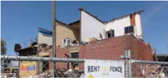
写真 1.取壊し予定の歴史的建造物（市内）
