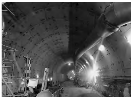
写真3 建設中のシールドトンネル内部
