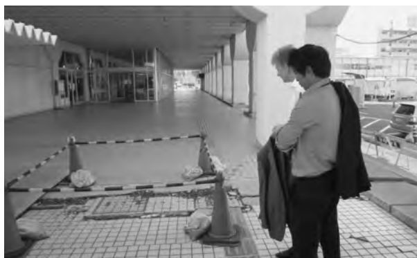
写真2 液状化による地盤沈下（水戸市）
