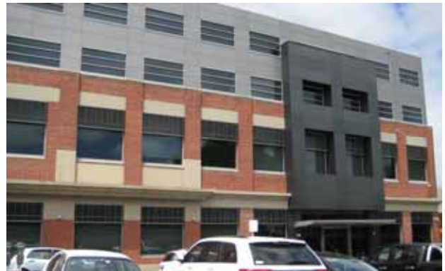
写真1 NDYメルボルン本社の外観
