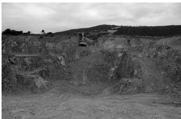
写真1 掘削中の発電所付近
