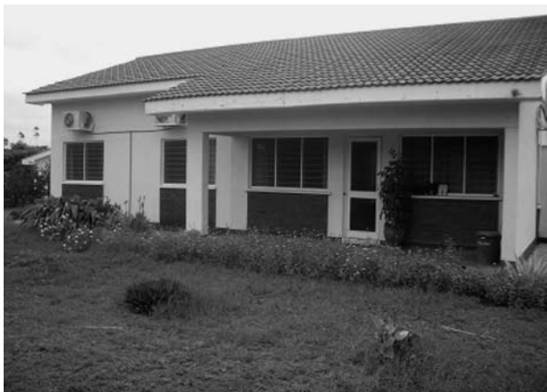
写真3 Base Campの宿舎
