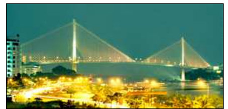
ベトナム バイチャイ橋建設事業
